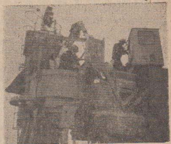
Cán bộ kỹ thuật và công nhân Công ty xây dựng thủy lợi 4 học tập chuyên gia lắp ráp được máy t-ôn bê-tông hiện đại MA-500 (CHDC Đức).
