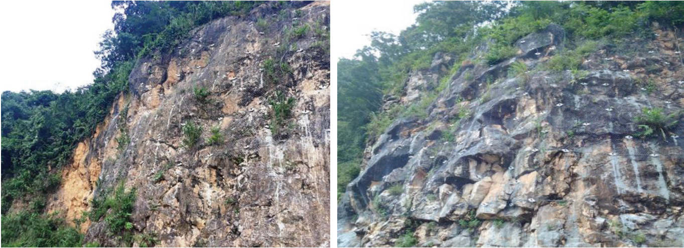
Hình 2. Hiệu quả ổn định bờ dốc chống đá lở của lưới thép cường độ cao chống ăn mòn trên quốc lộ 6 (10/2018).
