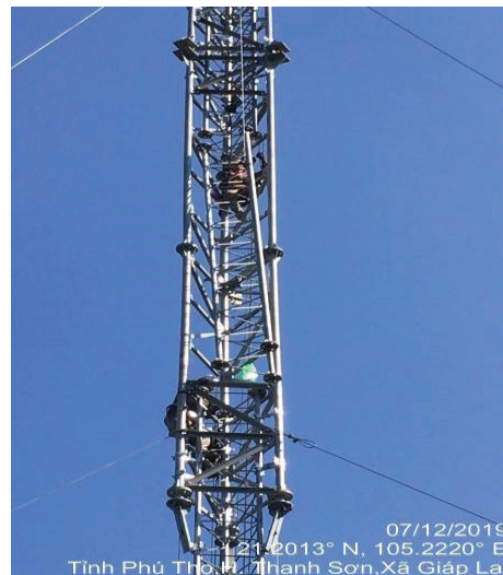
Hình ảnh triển khai thử nghiệm thay đổi cột mới tại Thanh Sơn - Phú Thọ, tháng 12/2019.
