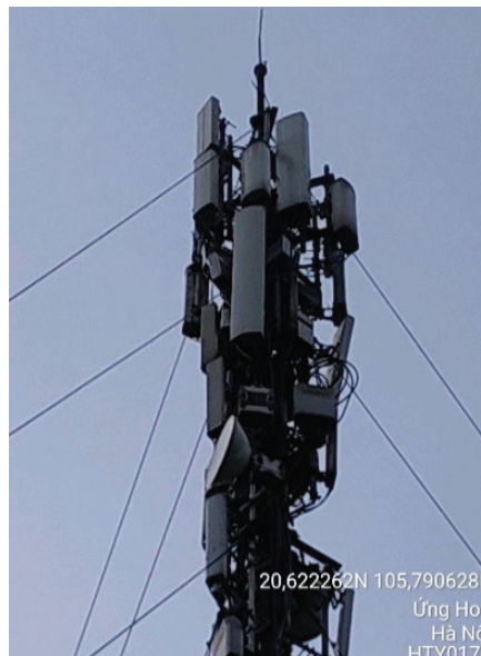
Cột ăng-ten xây dựng tại Kiến Thụy - Hải Phòng (A) và cột ăng-ten xây dựng tại Ứng Hòa - Hà Nội (B) được treo thêm rất nhiều thiết bị gắn kèm.
