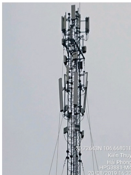
Cột ăng-ten xây dựng tại Kiến Thụy - Hải Phòng (A) và cột ăng-ten xây dựng tại Ứng Hòa - Hà Nội (B) được treo thêm rất nhiều thiết bị gắn kèm.
