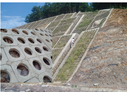
Phủ xanh bờ dốc nền đào không đạt yêu cầu khi trồng bằng thủ công trong ô geocell và tấm bê tông có lỗ tại đường cao tốc Bắc Giang - Lạng Sơn và Hạ Long - Vân Đồn.
