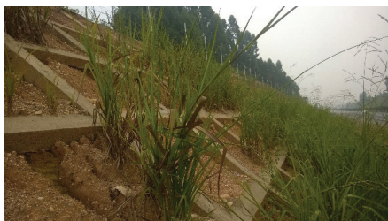
Phủ xanh bờ dốc nền đào không thành công khi trồng thủ công tại đường cao tốc Nội Bài - Lào Cai.
