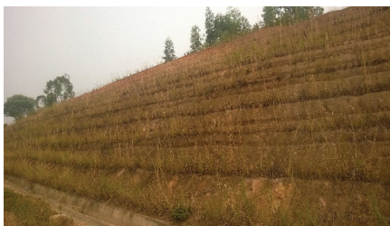
Phủ xanh bờ dốc nền đào không thành công khi trồng thủ công tại đường cao tốc Nội Bài - Lào Cai.
