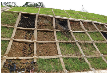
Phủ xanh bờ dốc nền đào không đạt yêu cầu khi trồng bằng thủ công trong ô geocell và tấm bê tông có lỗ tại đường cao tốc Bắc Giang - Lạng Sơn và Hạ Long - Vân Đồn.
