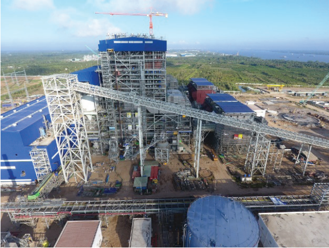
Hệ thống bốc dỡ, vận chuyển than tại Nhà máy Nhiệt điện Sông Hậu 1.
