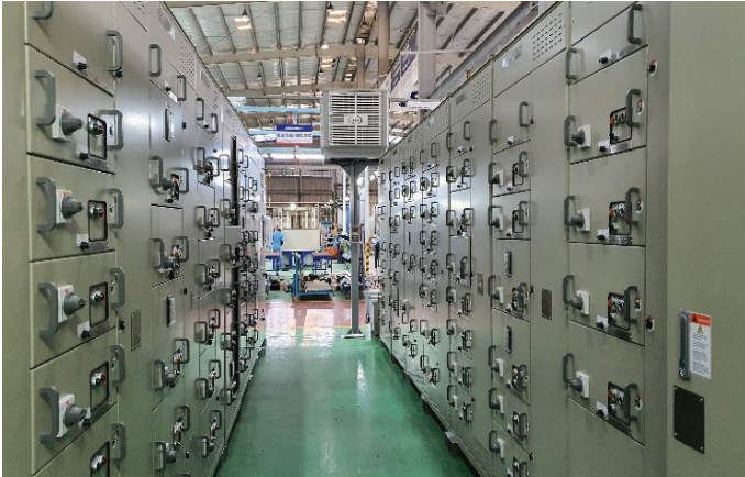
Hệ thống điện, điều khiển cho hệ thống bốc dỡ, vận chuyển than.
