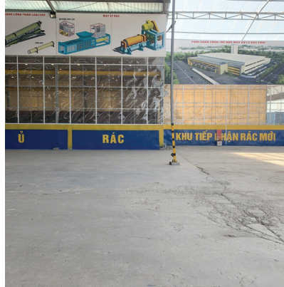
Khu tiếp nhận rác được thiết kế ngăn mùi, khép kín.
