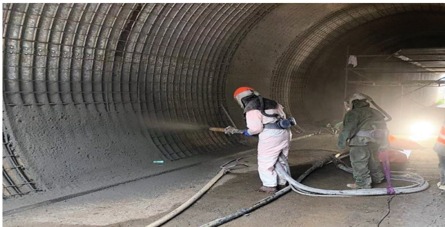
Bê tông phun cường độ siêu cao tại dự án khôi phục hầm dẫn nước Sevenans (Pháp).
