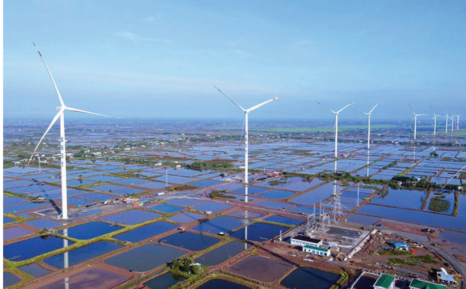
Vận hành hệ thống điện gió giúp giảm bớt sử dụng năng lượng hóa thạch.
