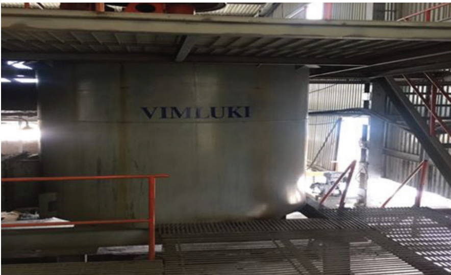
Thiết bị Tankcell đang được vận hành tại Nhà máy tuyển chì kẽm Chợ Điền thuộc Công ty CP Kim loại màu Thái Nguyên.
