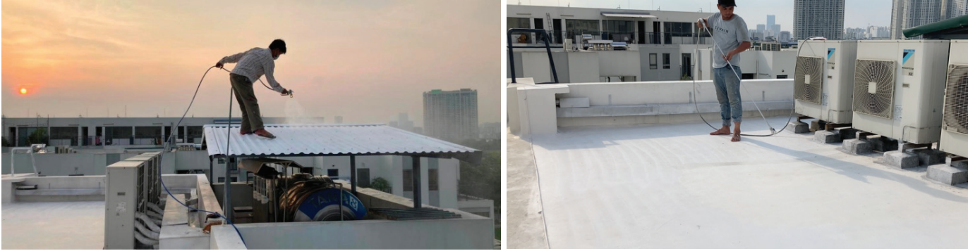
Sơn bức xạ RARE được thi công tại một biệt thự ở Hà Nội (trái) và mái tôn che bể nước cho một nhà dân sinh (phải) vào tháng 7/2022 bằng súng phun bã công nghiệp cho hiệu quả giảm nhiệt rõ rệt.
