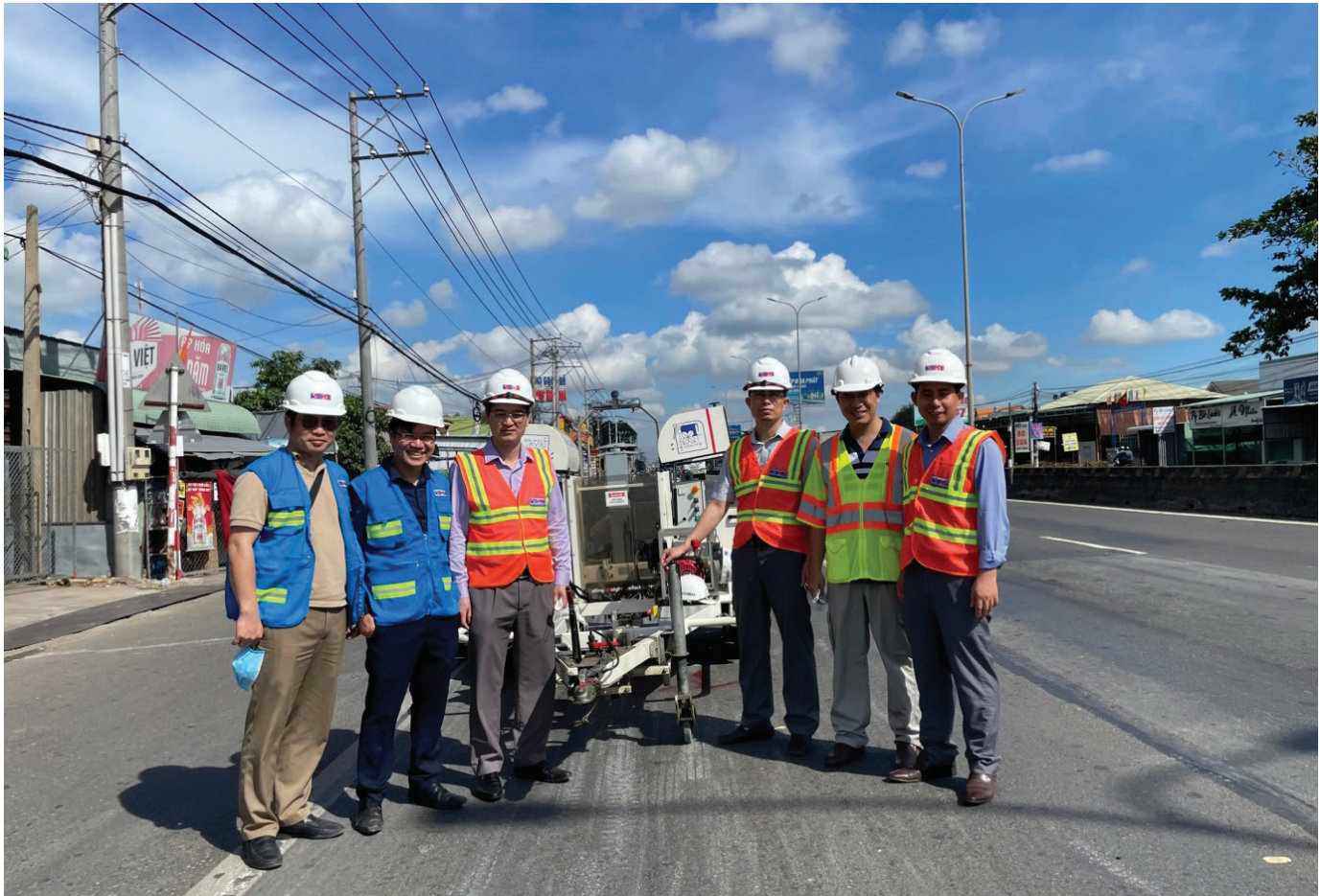
Đánh giá hiện trường bê tông nhựa chặt tái chế nóng tại trạm trộn sử dụng hàm lượng vật liệu bê tông nhựa cào bóc từ mặt đường cũ từ trên 25 đến 50%.
