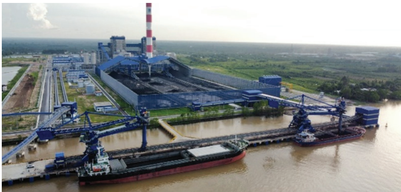
Hệ thống vận chuyển than cho Nhà máy Nhiệt điện Sông Hậu 1 do Viện Nghiên cứu Cơ khí thiết kế chế tạo.
