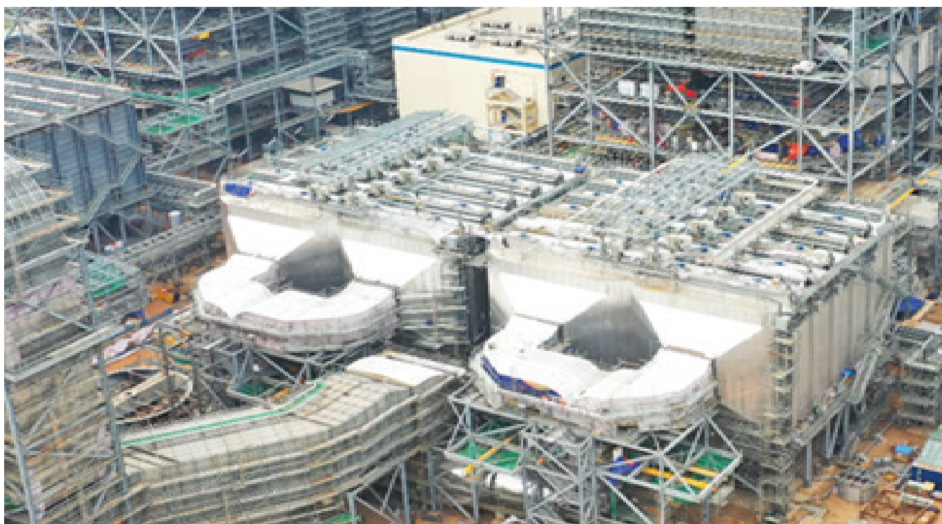
Thiết bị lọc bụi tĩnh điện của Nhà máy Nhiệt điện Nghi Sơn 2 do Viện Nghiên cứu Cơ khí thiết kế chế tạo.
