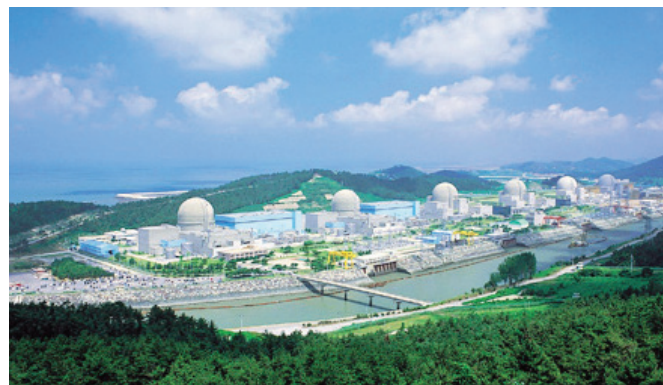
Nhà máy điện hạt nhân Yeonggwang tại Hàn Quốc.
