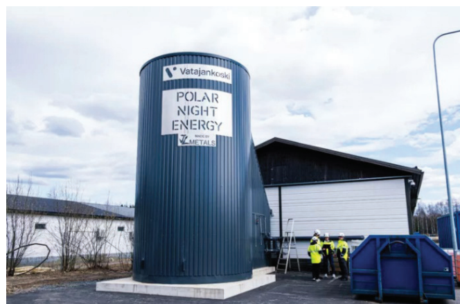
Trạm pin cát thương mại đầu tiên trên thế giới đặt ở Phần Lan. Nguồn: Polar Night Energy.
