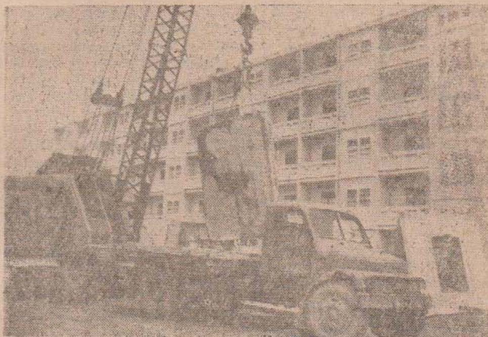
Phương pháp lắp ghép tấm lớn được thi công tại khu xây dựng nhà ở Trung-tư - Hà-nội.
