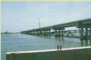
Công trình ngăn mặn giữ ngọt Thỏ Long (Thủy Thiên Huế) do Viện thiết kế bảng công nghệ đập trụ đỡ
