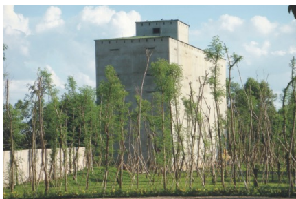
Mô hình nhà yến thông dụng xây bằng gạch, bê tông cốt thép
