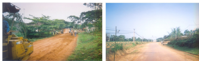
Hình 3: sử dụng vật liệu chống bụi bằng phương pháp trộn khô cho đường giao thông nông thôn chưa rải nhựa (trước và sau khi xử lý) tại Thanh Ba - Phú Thọ
