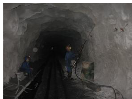
Đào lò sử dụng kíp vi sai phi điện tại mỏ than Hồng Thái
