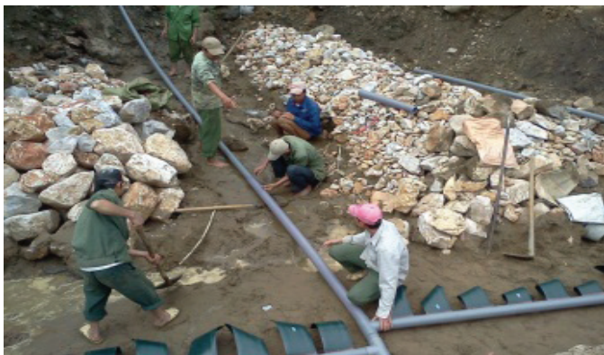
Thi công công trình đầu mối cấp nước sinh hoạt bằng công nghệ đập ngầm tại xã Chăn Nưa - Lai Châu
