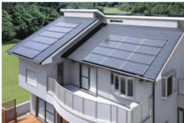
Tấm pin năng lượng mặt trời được lắp đặt trên mái nhà
