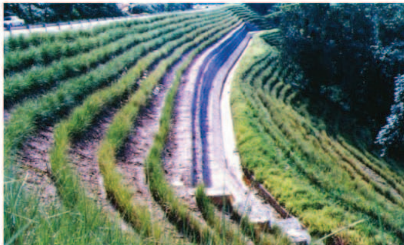
Thử nghiệm trồng cỏ vetiver chống sạt lở trên tuyến đường khu du lịch Bà Nà
