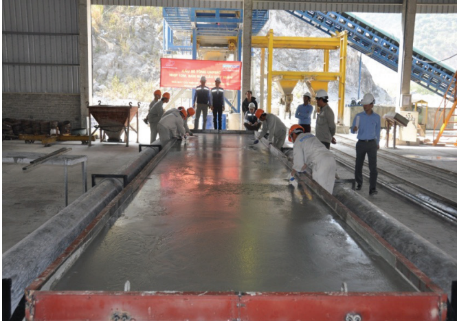
Đúc tấm dầm cầu theo công nghệ UHPC tại phân xưởng của IBST
