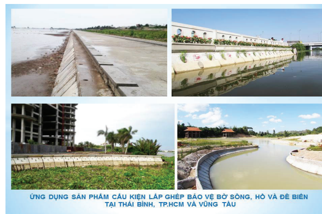
Thi công lắp đặt cấu kiện lắp ghép bảo vệ bờ sông, hồ và đê biển
