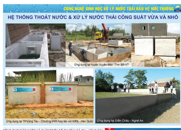
Thi công lắp đặt trạm xử lý nước thải của BUSADCO trong các dự án môi trường
