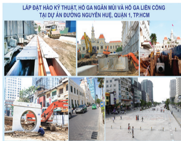
Xây dựng đồng bộ hệ thống hạ tầng tại đường Nguyễn Huệ, Quận 1, TP Hồ Chí Minh
