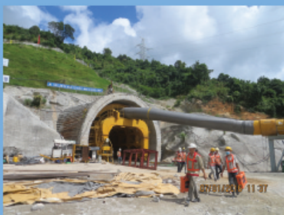
Xử lý chống thấm hầm Đèo Cả
