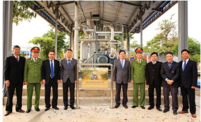
Thứ trưởng Bộ Công thương Đỗ Thắng Hải, Tổng giám đốc Petrolimex Trần Văn Thịnh, Lãnh đạo Cục Cảnh sát phòng cháy, chữa cháy và cứu hộ, cứu nạn... tại Lễ gắn biển công trình hệ thống thu hồi hơi xăng dầu tại Tổng kho xăng dầu Đức Giang
