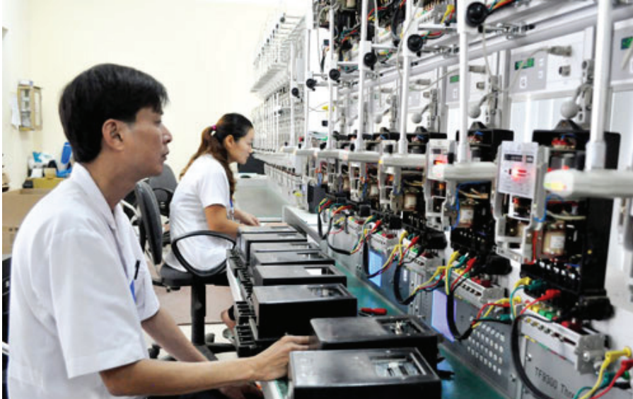
Dịch vụ kiểm định công tơ điện
