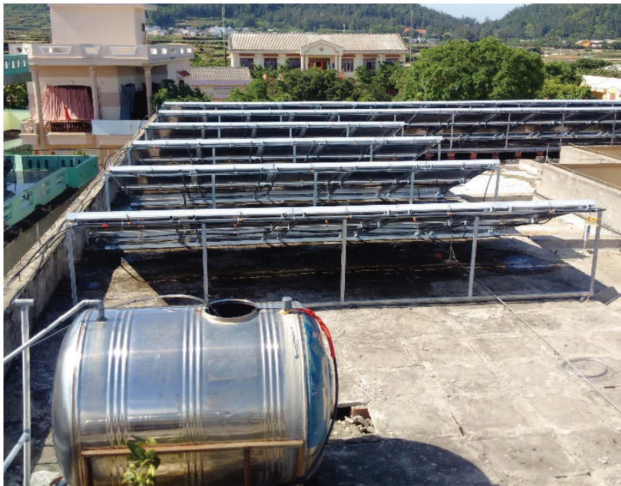
Mô hình ứng dụng năng lượng mặt trời lọc nước biển, nước lợ tại Nam Định.
